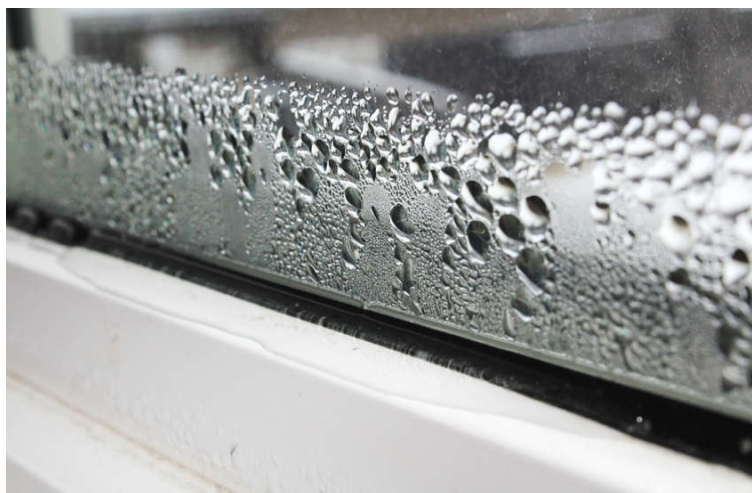
25 pav. Drėgmės kondensacija ant stiklo paketo išorinio stiklo
