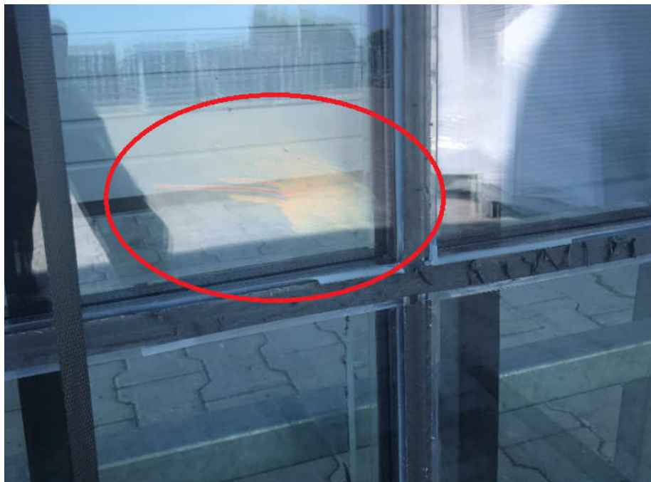
29 pav. Cheminis garavimas stiklo paketo viduje, viršijus rekomenduojamą 60 °C temperatūrą
