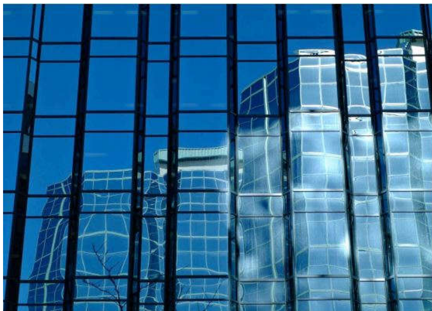
24 pav. „Bangavimo“ efektas, priklausomai nuo stiklų įsigaubimo/išsigaubimo, grūdintų stiklų bendro ir vietinio išlinko ir kt.
